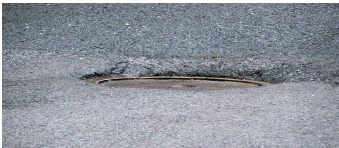
Una alcantarilla hundida provoca un desnivel de varios centímetros que puede resultar muy peligroso para un vehículo inestable como una moto.
