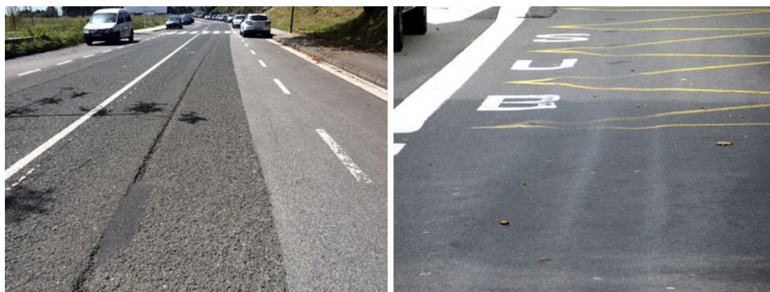
Los surcos longitudinales y las roderas de los carriles que soportan tráfico pesado pueden modificar la trayectoria de la moto, motivo suficiente para evitarlos.
