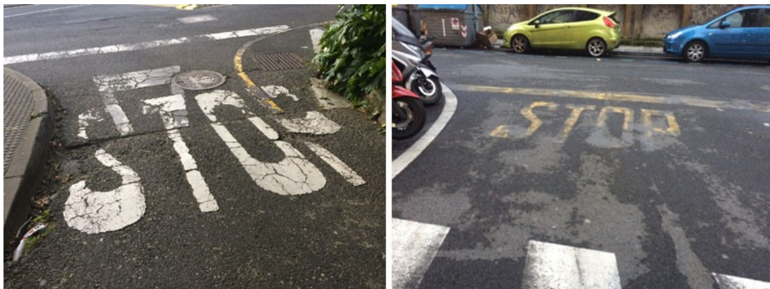
La pintura negra no se ve, es igual de deslizante y siempre acaba dejando al descubierto la antigua señalización.
