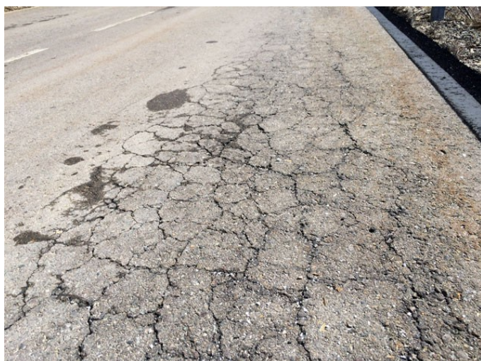
El asfalto cuarteado no supone un riesgo en un primer momento, pero ya está avisando de que pronto lo será, y debería ser reparado cuanto antes.
