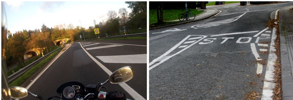
Dos intentos de calmado de tráfico sin un gran resultado. Salida de autopista (i) de dos carriles reconvertida a sólo uno con una casi inapreciable chicane y sin reducción de anchura del carril disponible. Curioso y poco efectivo estrechamiento de carril (d) donde no hay sitio ni para la marca vial de STOP.
